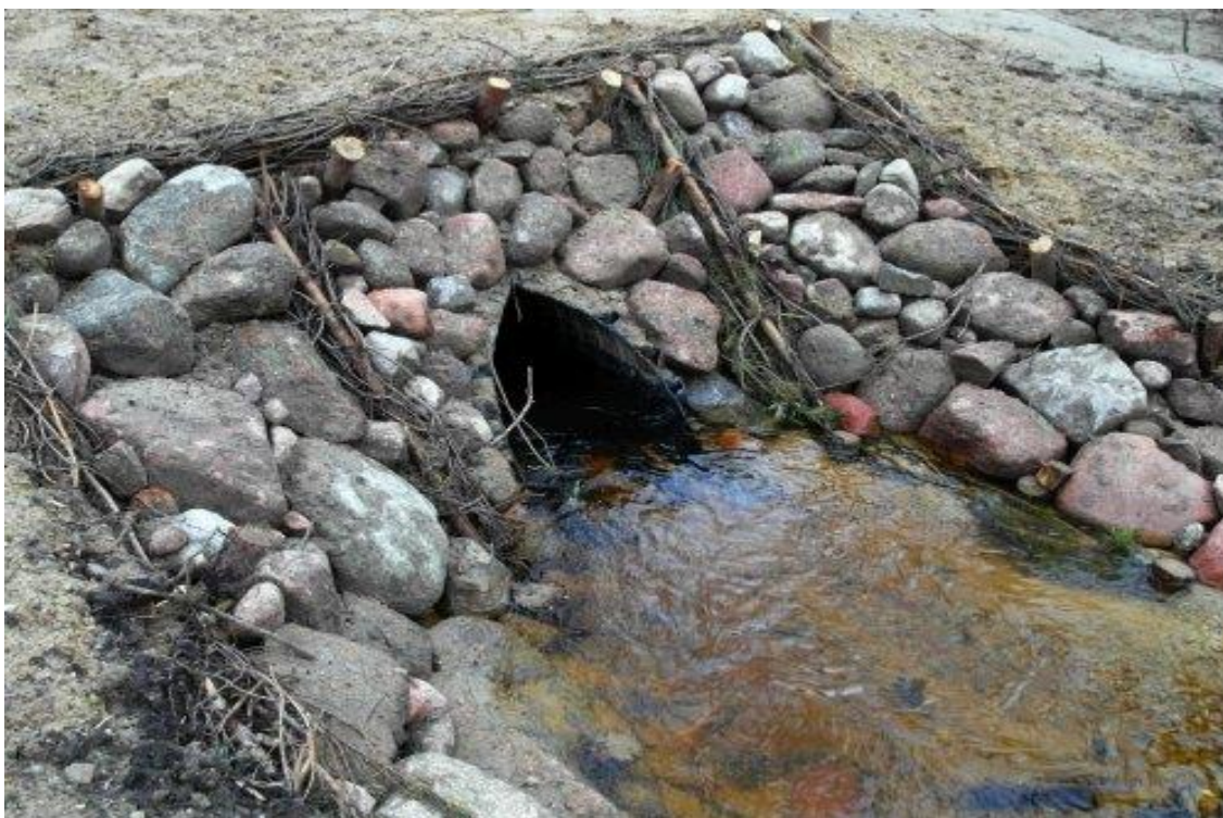
Jeden z wykonanych przepustów. Przez przepusty wykonane w ramach projektu woda ma przepływać jedynie w czasie wysokich poziomów wód w zlewni bezpośredniej danego cieku. sierpień 2017, fot. B. Grzebułska
