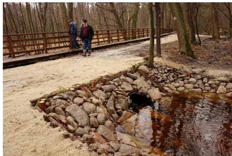
Ob. 4. Jeden z wykonanych przepustów. Marzec 2017
