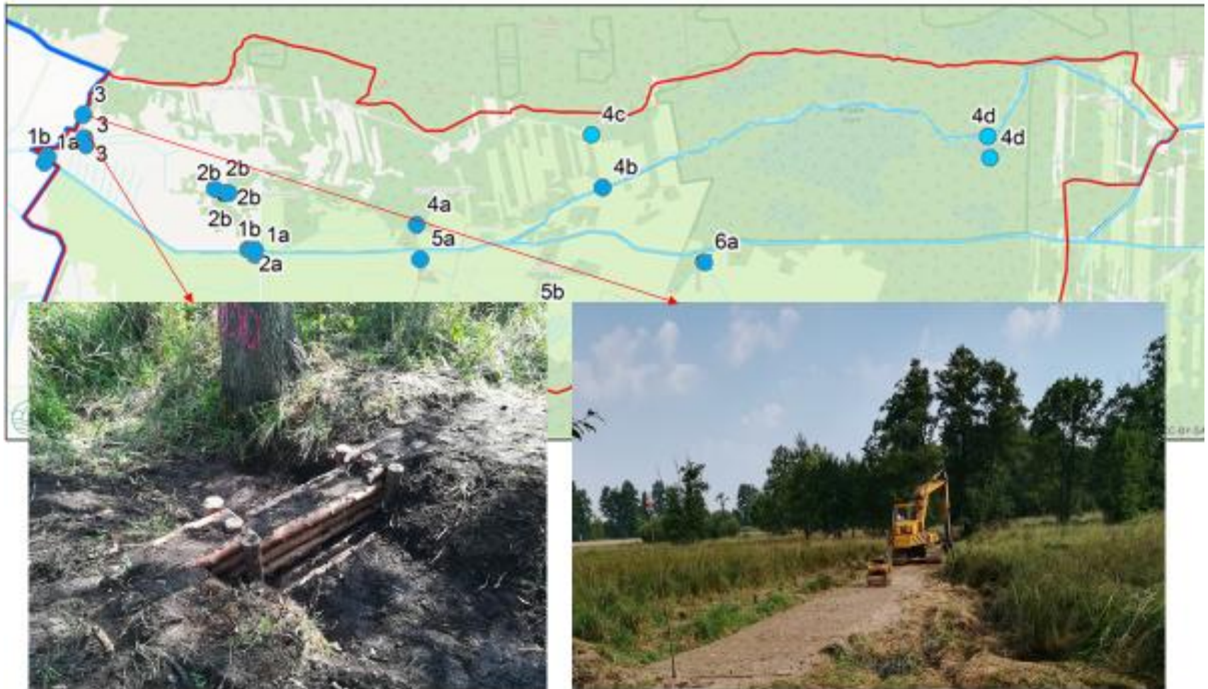
Obiekt 3 - Przebudowa 2 rowów polegająca na budowie progów oraz podwyższenie grobli
