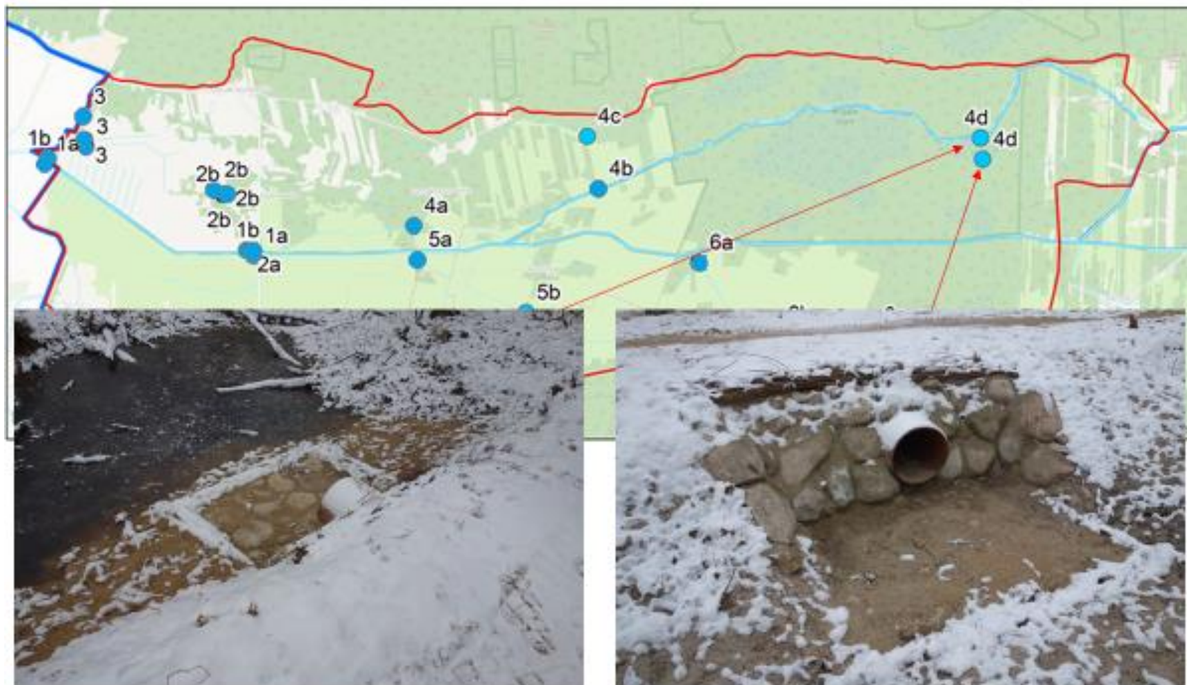
4d Przebudowa przepustów
