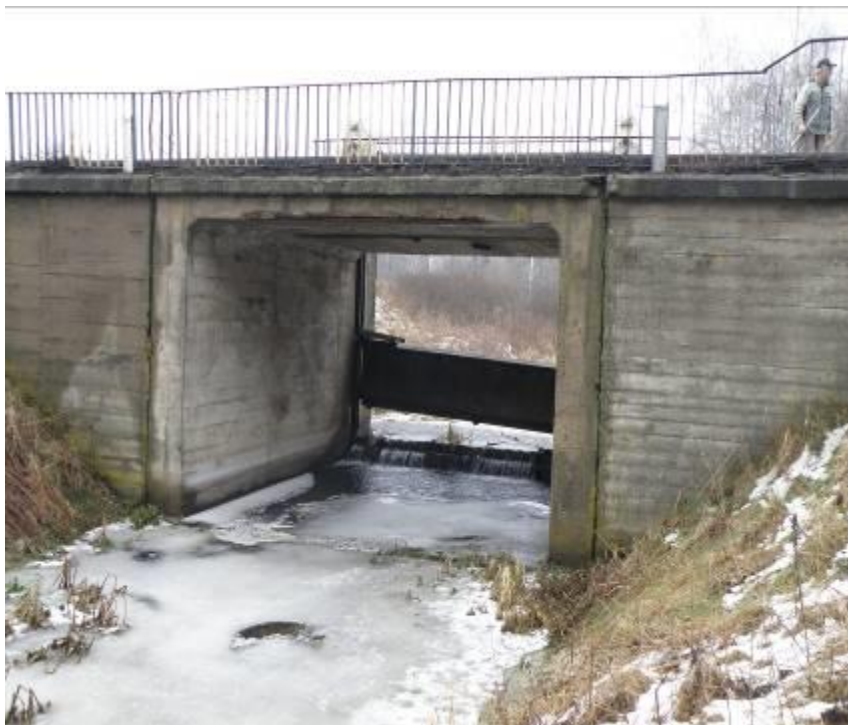
Jaz na kanale Kromnowskim km 3+000
