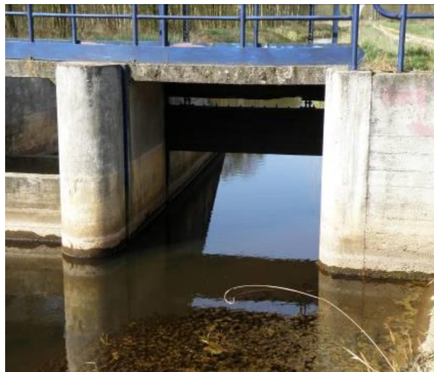
Jaz Aleksandrów, kanał Łasica 23+575 od strony wody górnej
