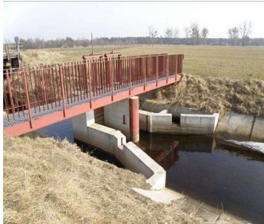
Kanał Olszowiecki km 2+900 zastawka betonowa z przepławkami
