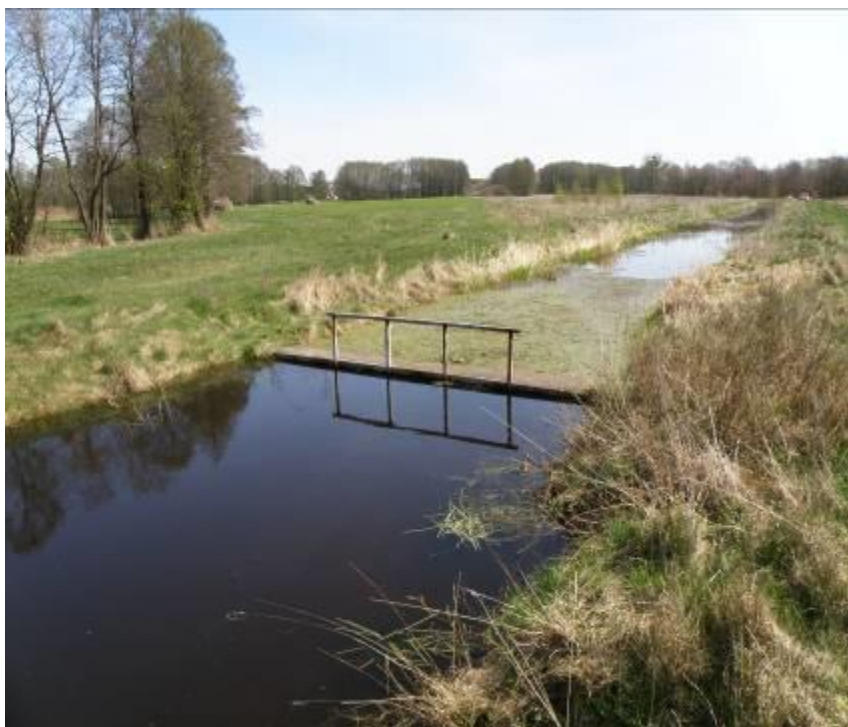
Zastawka na kanale Ł-9 km 2+217 Widok od strony wody dolnej
