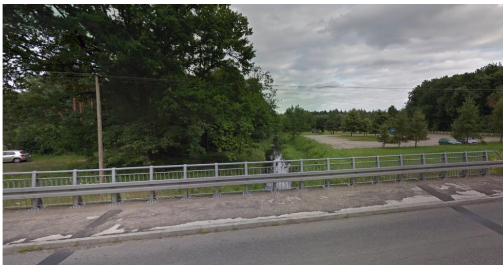
Rycina 17: Most drogowy DW579. Źródło: Street View.
